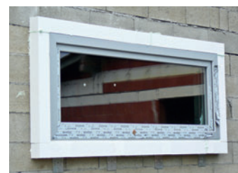
Obr. 2 - Dotvoření hranolu z EPS
