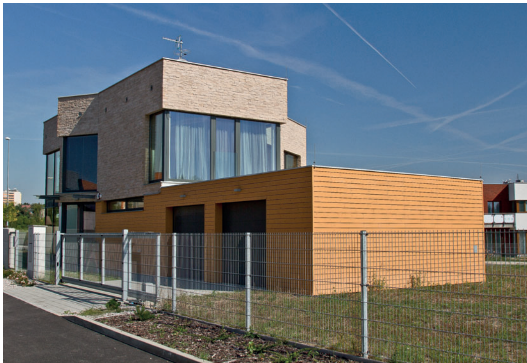
Architektonicky a funkčně zajímavá pasivní vila v Horních Počernicích
