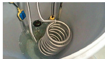
Obr. 2: Tepelný výměník v nádržích AS-GW/AQUALOOP
