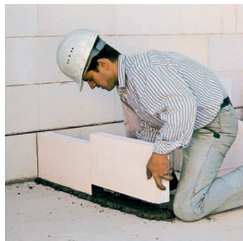
Zhotovení patní vrstvy zdiva příčky 115 mm
