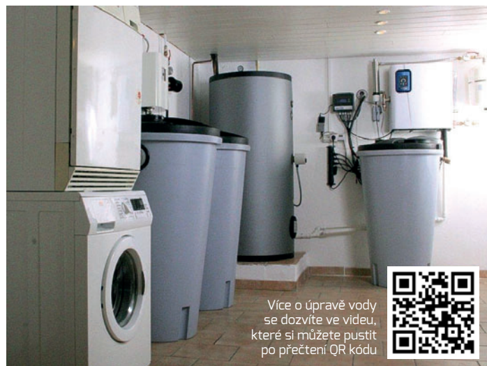
Obr. 1: Celá technologie na úpravu šedé vody včetně zásobníku teplé užitkové vody
