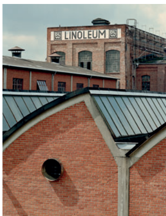
Továrna na linoleum v Delmenhorstu
