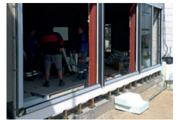
Obr. 3 - Montáž sestavy k úrovni podlahy
