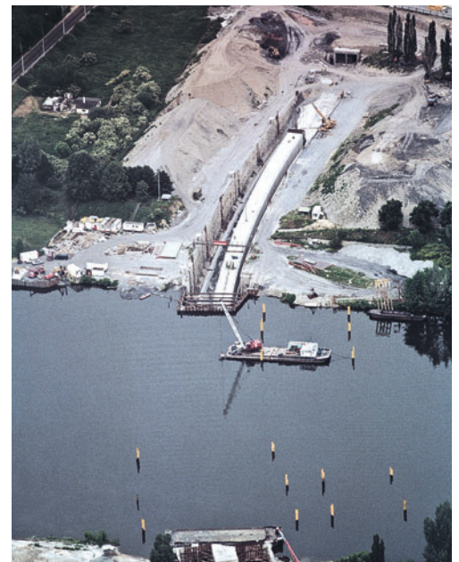
Plavené tunely na trase metra IV.C1 pod Vltavou
