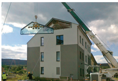
Prosklení štítové stěny systémem NOframe4
