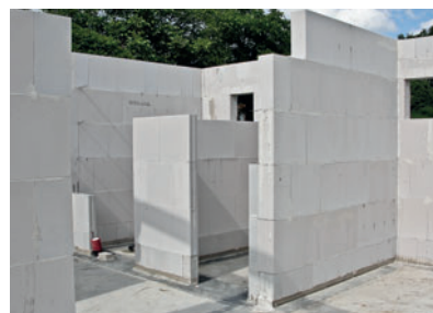
Vápenopískové zdivo se vyznačuje přesností a čistotou hrubé stavby
