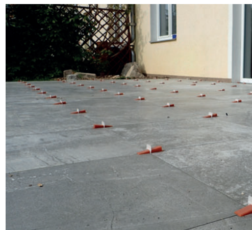
Rovnou plochu, bez jediného výkyvu zajišťují speciální vyrovnávací klínky.
