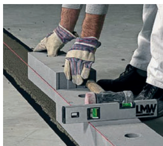
Izolační blok VAPIS IZO do patní vrstvy zdiva snižuje tepelné ztráty po celou dobu existence stavby
