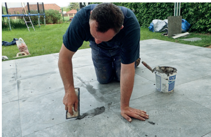
Správný výběr spárovací hmoty. Vysoce flexibilní spárovací hmota pro spárování dlažeb na terasách.
