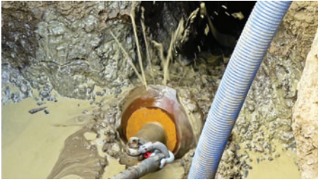
Postupné rozšiřování pilotního vrtu profily 300, 500 a 700 mm
