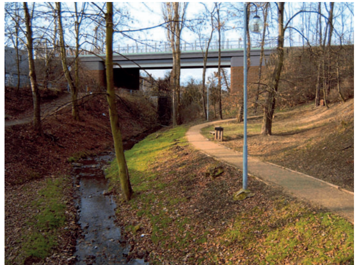
Modernizace úseku Rokycany – Plzeň na III. tranzitním koridoru
