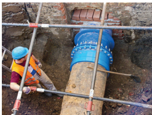
Tvarovka od výrobce Ludwig Frischhut (člen GSK) DN 800, Praha rok 2011
