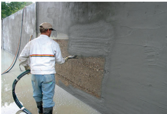
Strojní nanášení ochranného systému
