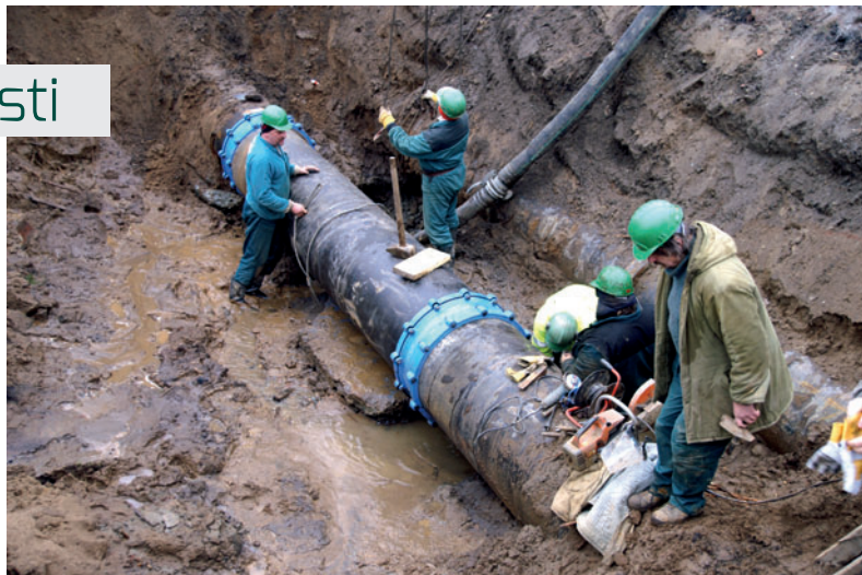
Oprava vodovodní havárie ul. Formánkova – Praha 8
