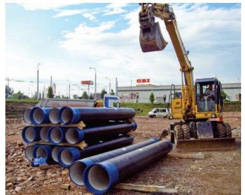
OBI Pardubice: Potrubí Electrofresh DN 500 s těžkou protikorozní ochranou - TT páskou
