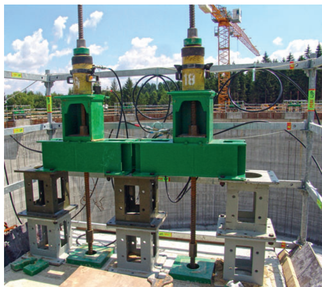
Ocelová konstrukce s převážkou, stoličkami a hydraulickými válci
