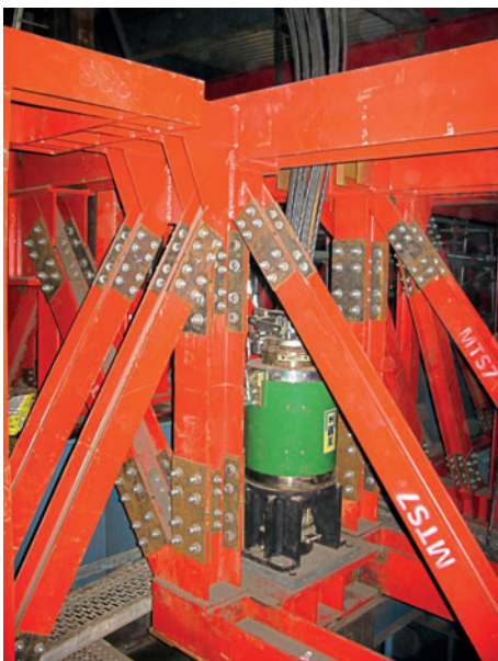
Hydraulický lis s nosností 200 t osazený na provizorní konstrukci
