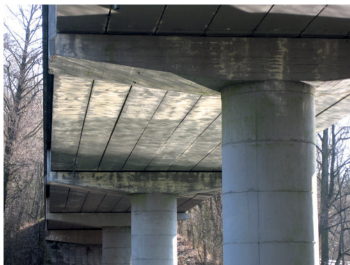
Most přes Želivku - Pohled
