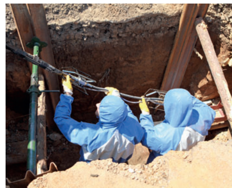
Provádění plněstrukturálního PU nástřiku 3M
