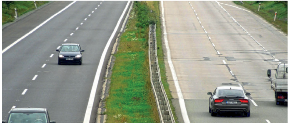
D1 Oprava AB vozovky km 193,8 - 199,3 L
