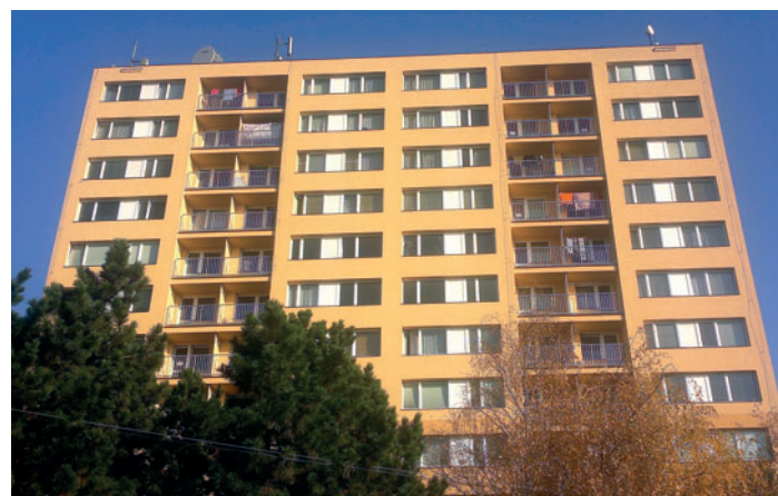
Zateplení panelového domu Mezilesí
