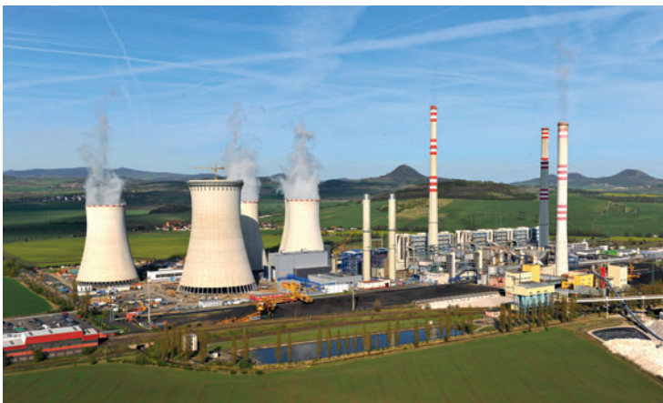
I v Elektrárně Počerady je nový zdroj, 840MW paroplynový cyklus, těsně před dokončením
