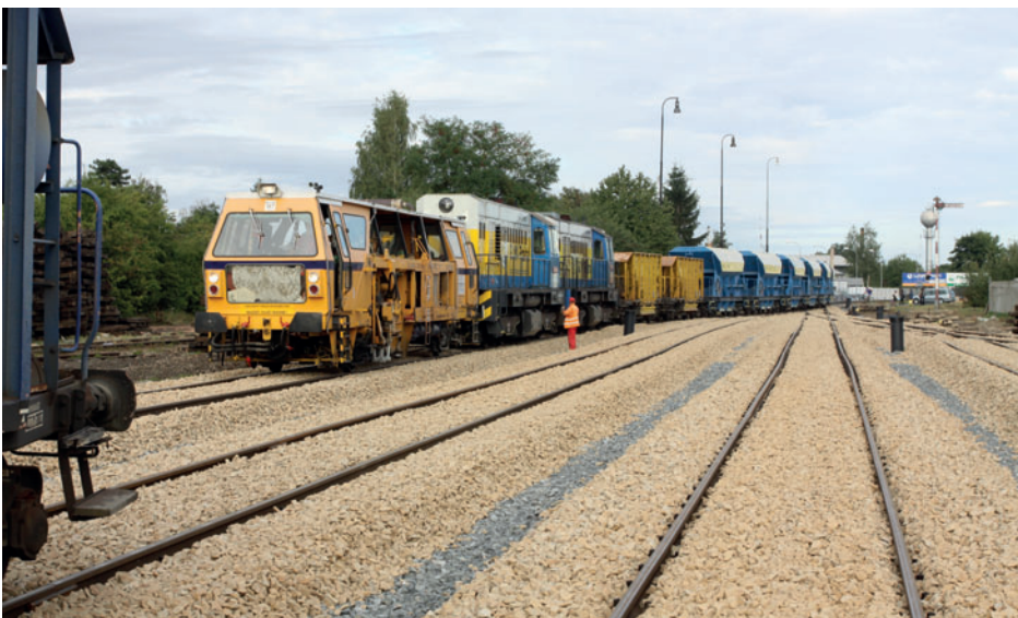
Stanice Rudná. Pracovní vlak na rekonstruovaných kolejích
