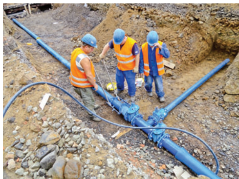
Pokládka potrubí v Děčíně, ulice Kamenická
