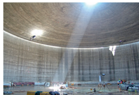
Interiér nádrže pod zdvihanou střechou - hra světla
