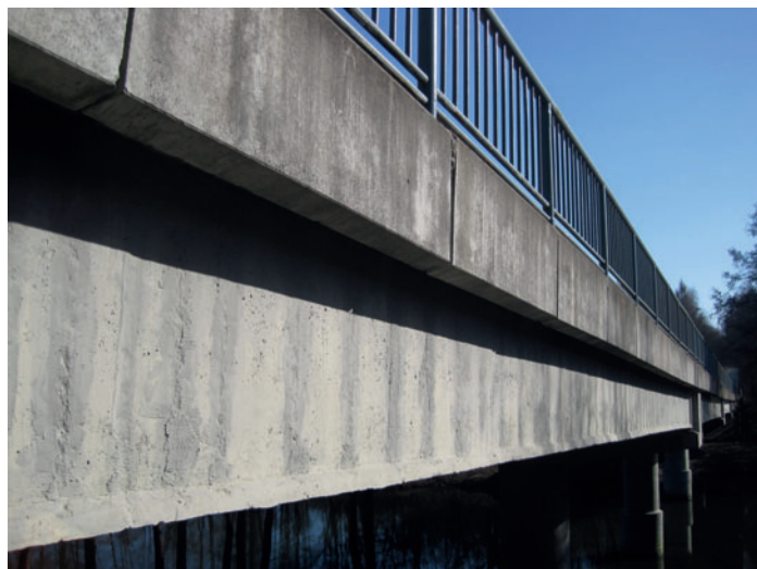
Most přes Želivku - Soutice
