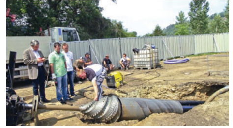
Finální vymoření vrtací hlavy včetně PE chrániček
