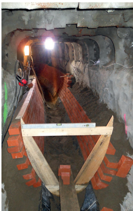
Oprava havárie kanalizační stoky Prosecká
