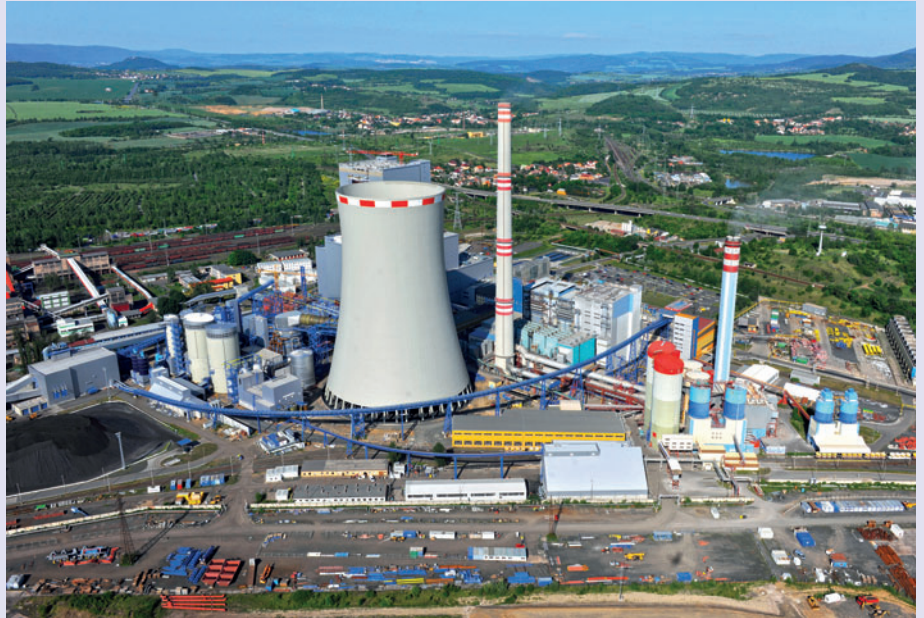
Nový 660MW blok v Elektrárně Ledvice již čekají jen finalizační práce
