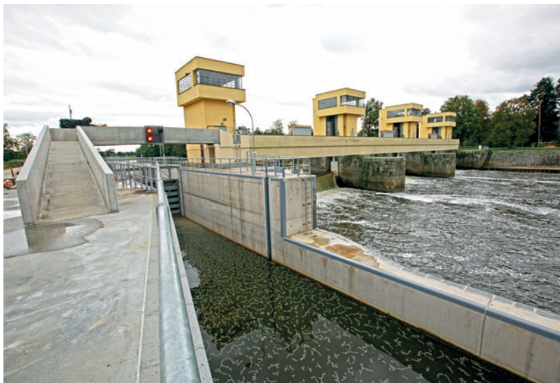
▲ Plavební komora Hluboká
