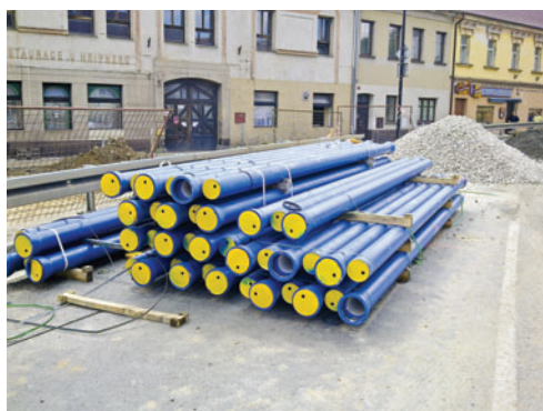
Potrubí Electrofresh DN 150 připravené na pokládku v Přešticích
