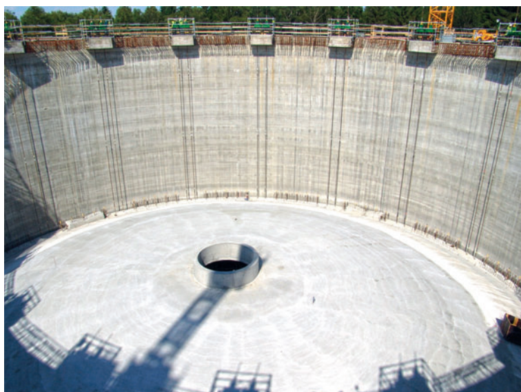
Zdvihání střechy nádrže na předpínacích tyčích
